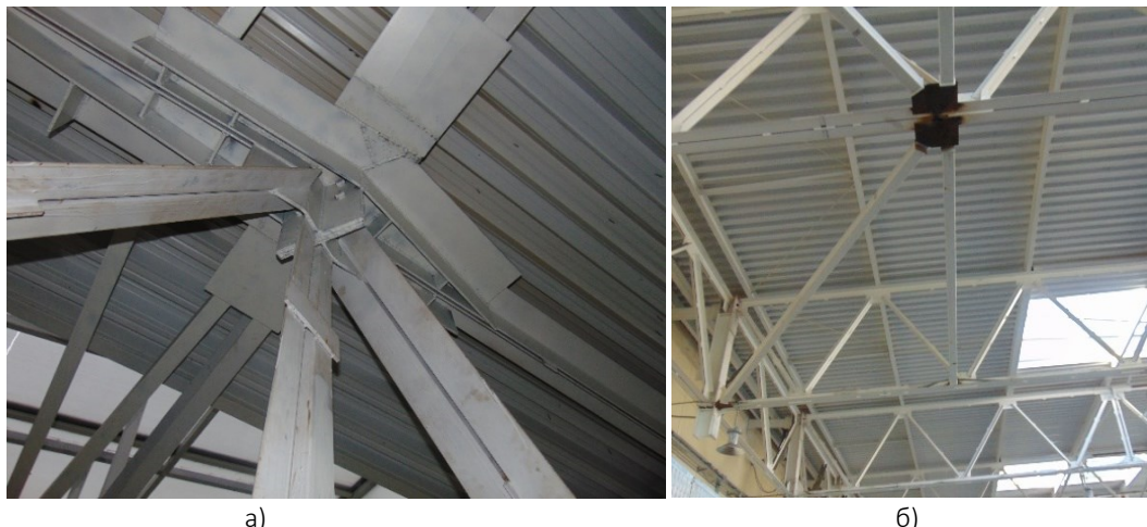
Рис. 3. Усиление каркаса и ферм: а) стабилизация положения аварийных ферм пролетом 30 метров; б) монтаж дополнительных связей и распорок
